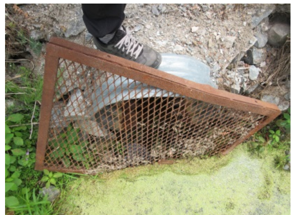
Photo 18 : Grillage qui protège le ponceau de sortie du marais au sud-ouest du lac Fraser
