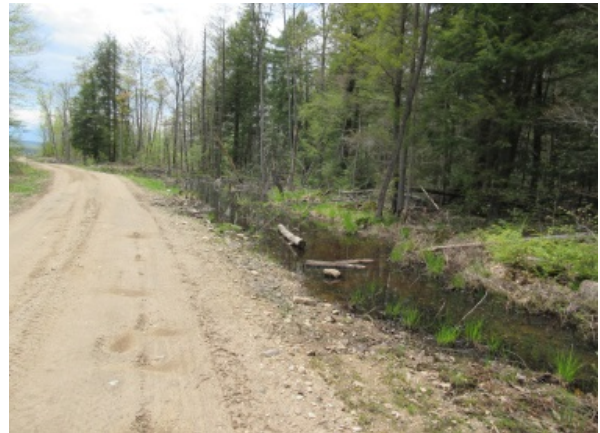
Photo 10 : Fossé de drainage donnant naissance au marécage forestier au nord du lac Fraser
