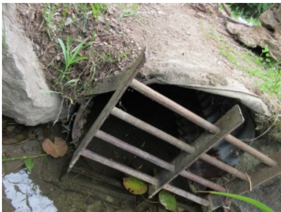
Photo 17 : Le ponceau du ruisseau séparant le lac Fraser du lac Bell protégé par un grillage à barreaux
